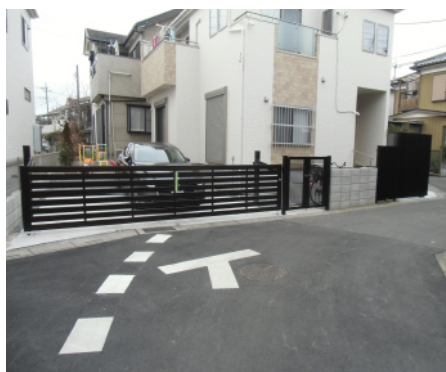
上げ下げゲート・門扉
