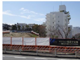
建設予定地全景
