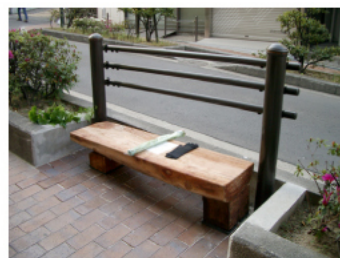
ベンチの設置
