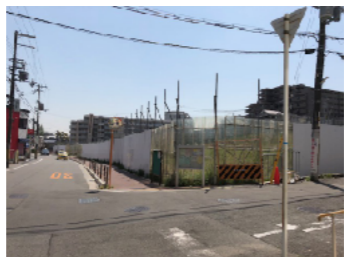
マンション建設予定地
