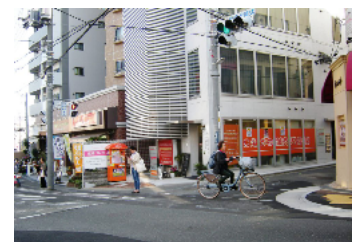
駅西道路の整備
